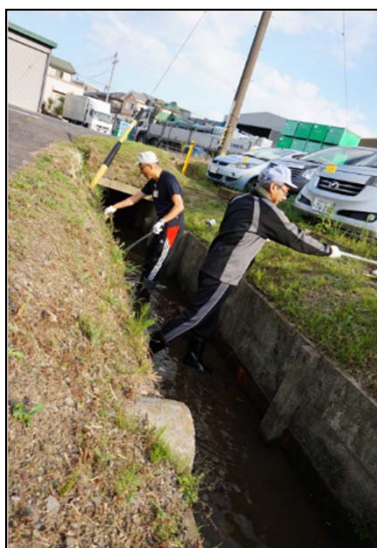
用水路の清掃①
